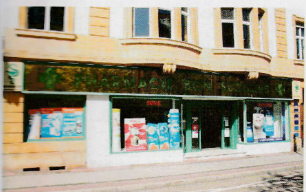
Pharmacie Bon Secours - 18 av. Leclerc de Hauteclouque
